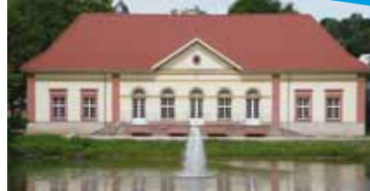
Südlich von Schloss und Kirche führen gerade Baumalleen zu der 1731 errichteten Orangerie .
