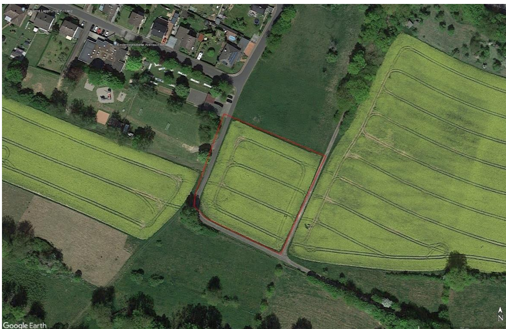
Begutachtet wurde der rot umrandete Bereich.
