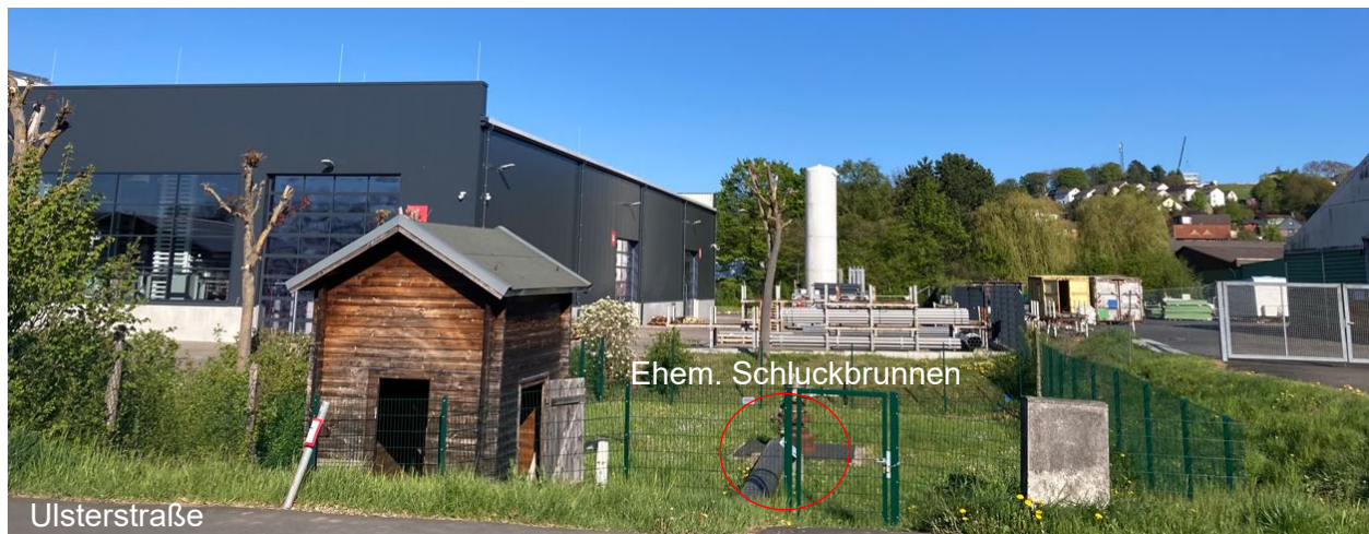
Abbildung 4 Bild ehem. Schluckbrunnen 14
